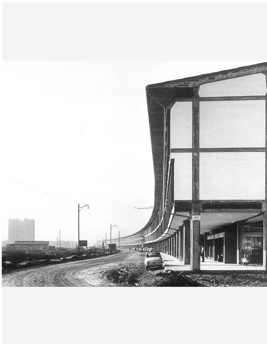
Vista generale del Treno, nel quartiere Barca ancora in costruzione (Archivio Giuseppe Vaccaro, in Mulazzani 2002, p. 211)
